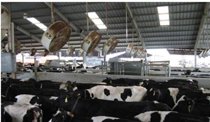
Bild 7. Flera rader med fläktar riktade åt samma håll ger en jämn luftgenomströmning i samlingsfållan. Foto: Delaval AB.
