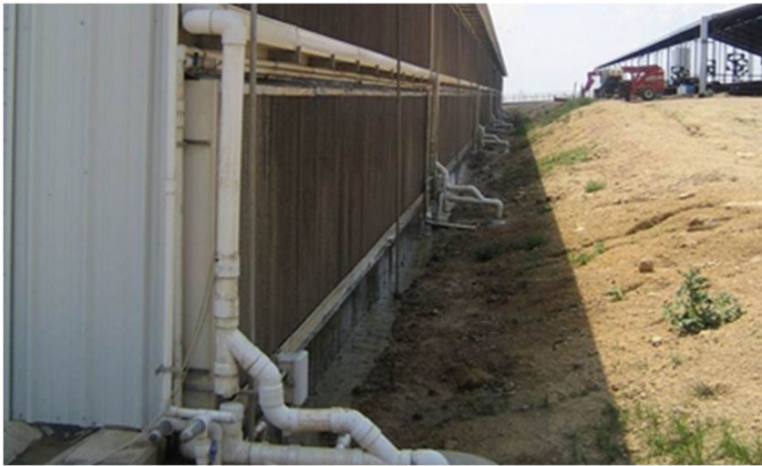
Bild 14. Genom att luftintaget sker genom så kallade "cooling pads" med strömmande vatten kyls ventilationsluften ner.
