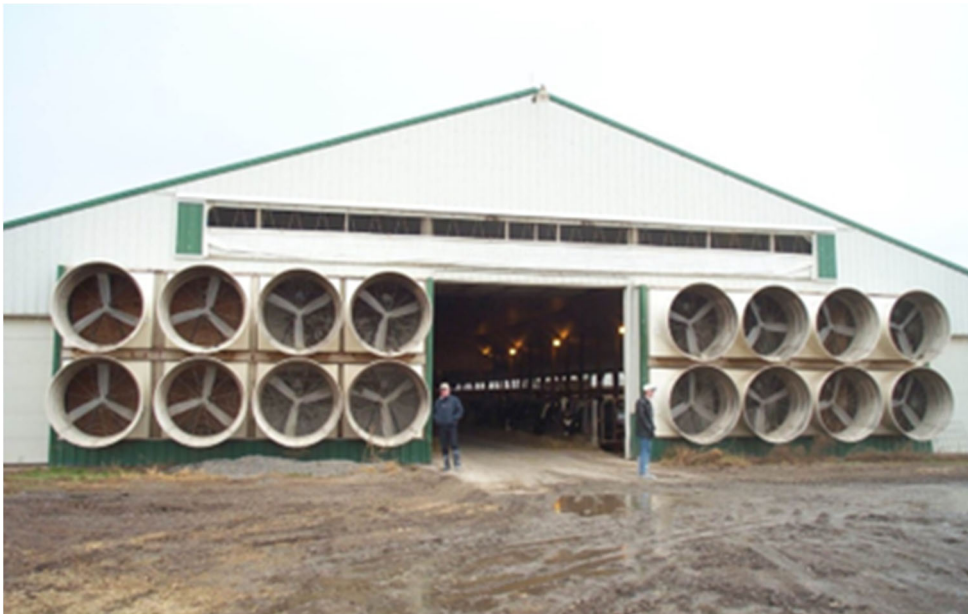
Bild 8. Tunnelventilation har en bättre kylande effekt än vanliga fläktar men nackdelen är en stor elförbrukning. På denna bild är det vinter och gardinerna längs husets långsidor är öppna. Under vintern fläktas huset med naturlig ventilation, eventuellt med några hjälpande cirkulationsfläktar. Foto: Delaval AB.
