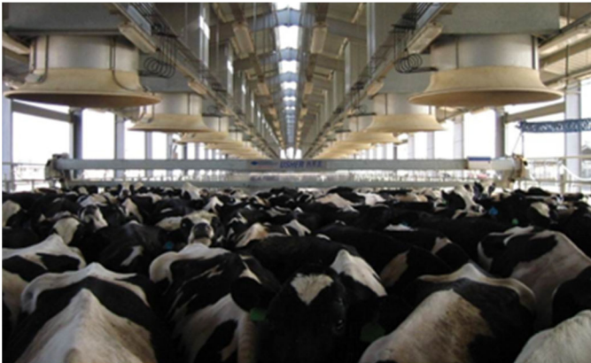
Bild 11. Luften trycks ned över korna. Vid varje fläkt sitter ett vattenmunstycke som bildar en avkylande dimma. Dessa kan placeras över samlingsfållan och är ganska vanlig i de delar av världen med torrt och varmt klimat. Foto: Delaval AB.
