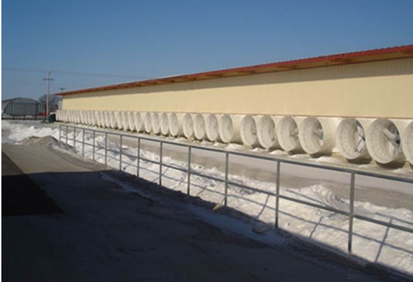
Bild 9. Cross ventilation liknar tunnelventilation men luften dras från ena långsidan till den andra. Foto: Delaval AB.
