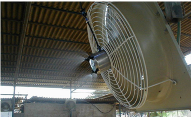
Bild 12. Ett vattenmunstycke framför en fläkt åstadkommer en nerkylande dimma i stallen. Foto: Delaval AB.
