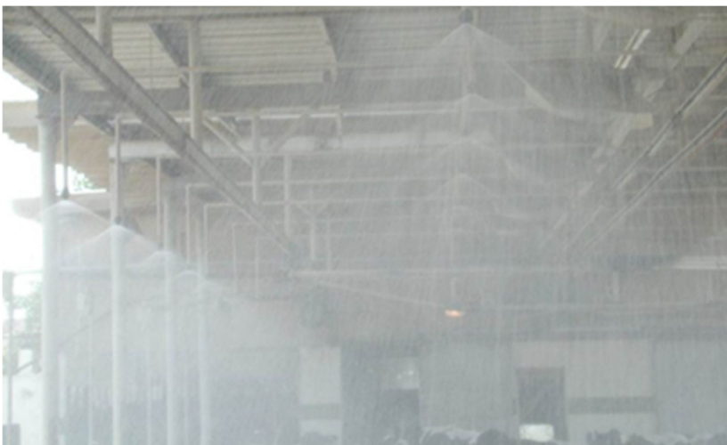
Bild 10. I varma länder utomlands är det vanligt med duschning över samlingsfällor. Foto: Delaval AB.
