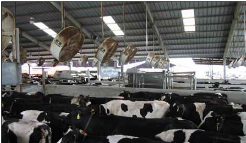
Bild 1. Flera rader med fläktar riktade åt samma håll ger en jämn luftgenomströmning i samlingsfållan (Foto: Delaval AB).
