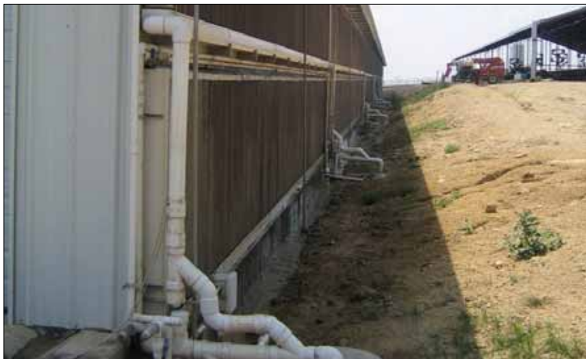
Bild 8. Genom att luftintaget sker genom så kallade "cooling pads" med strömmande vatten kylv ventilationsluften ner.
