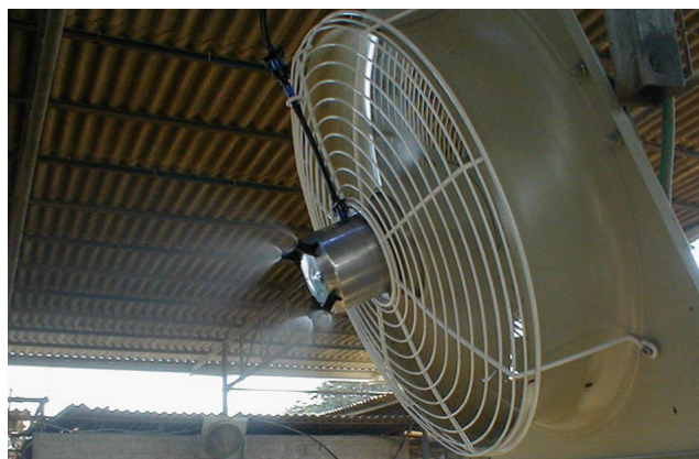
Ett vattenmunstycke framför en fläkt åstadkommer en nerkylande dimma i stallet (Foto: Delaval AB).
