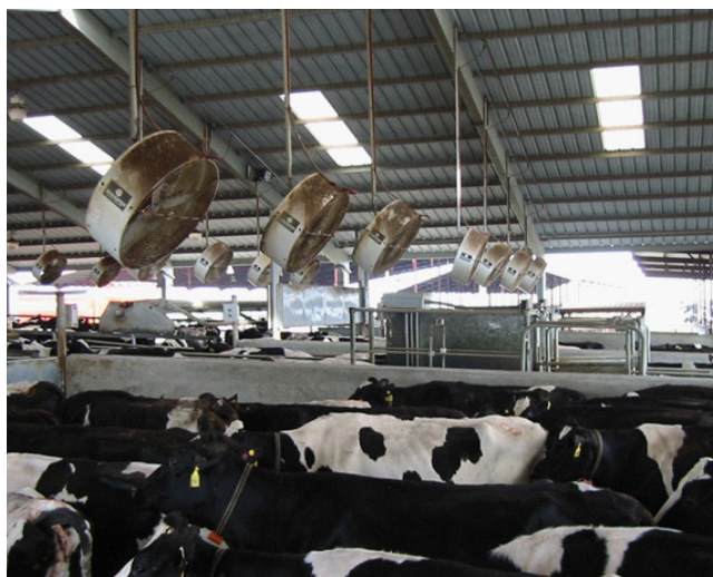
Fläktventilaion. Foto: Delaval AB.
